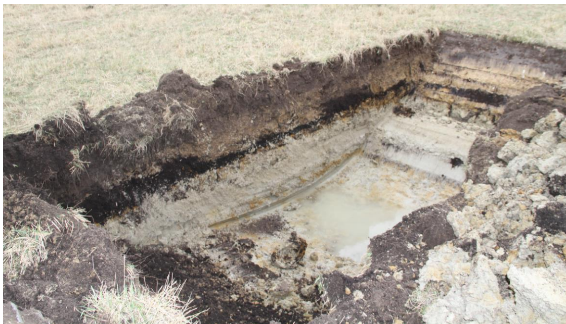
Figur 3. Fotoet viser en af de i alt 12 søgegrøfter lavet inden for område 1. Fotoet viser, at der er ler i bunden og et slamlag fra den tidligere sø/mose. Areal, hvor vådområdet etableres, er i dag ekstremt drænet med masser af tværgående dræn, der som støder ind i hoveddrænene. Det øverste lag, pløjelaget, graves af.
