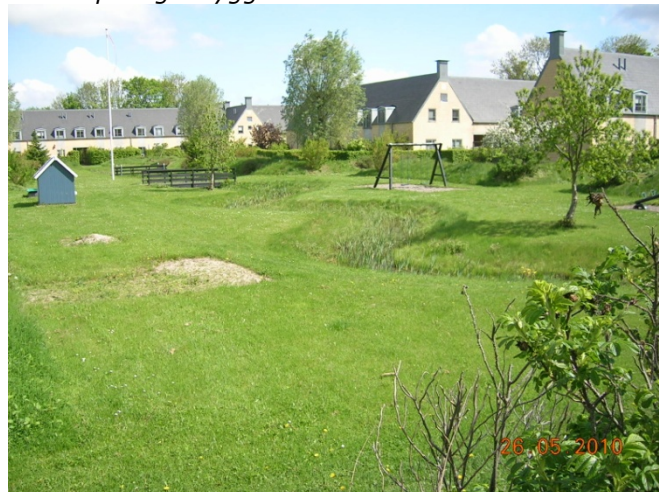
Lokal håndtering af regnvand ved Jonstrupvangbebyggelsen.
