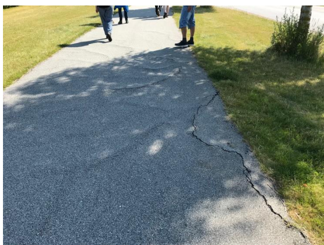
Billede 2. Ny allébeplantning skal plantes på en måde, så fremtidige rodproblemer under belægningen undgås. Afstanden til stien og valg af træart er afgørende.
