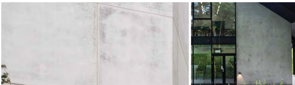
Beton – primært materiale
