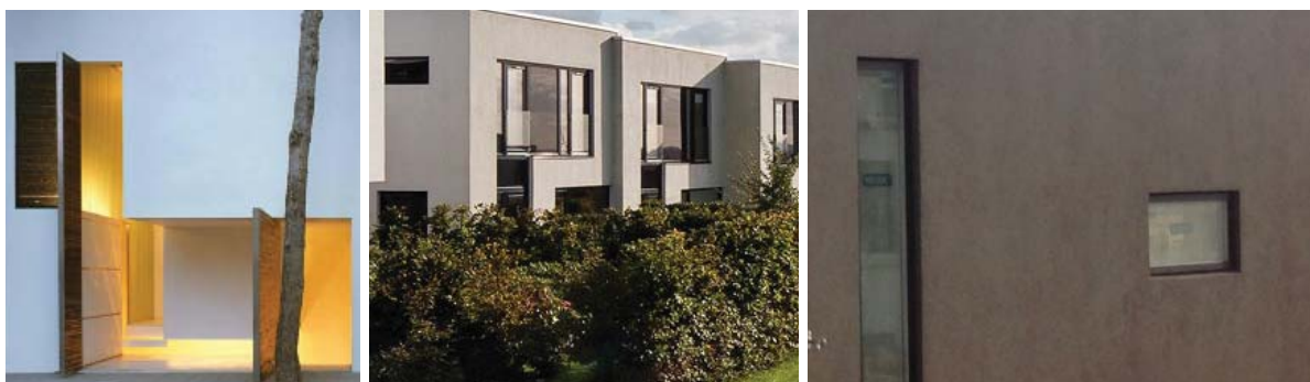
Filtset og pudset mur
