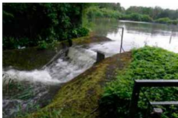
Overløb af regnvand ved regnvandsbassin på Ballerupvej
