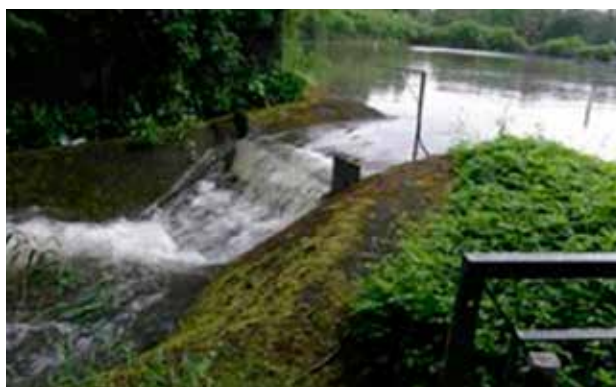
Overløb af regnvand ved regnvandsbassin på Ballerupvej.
